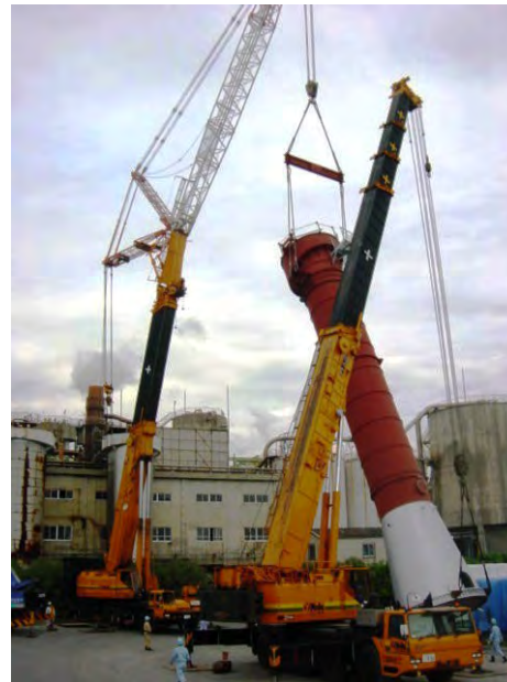
塔槽類 据付工事
