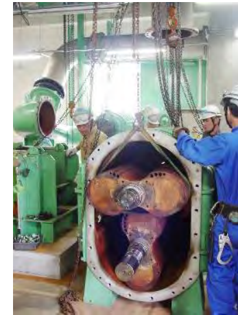
真空ポンプオーバーホール
