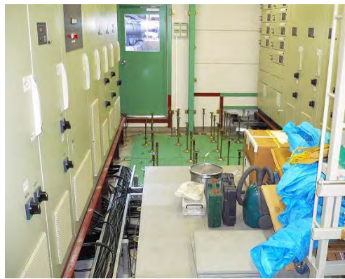
電気室新設(配電盤等設置他)
