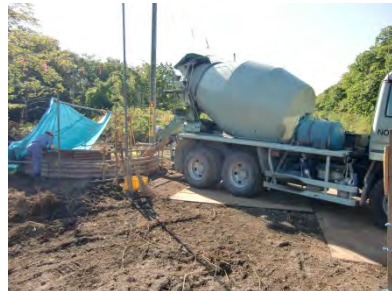
基礎コンクリート打設
