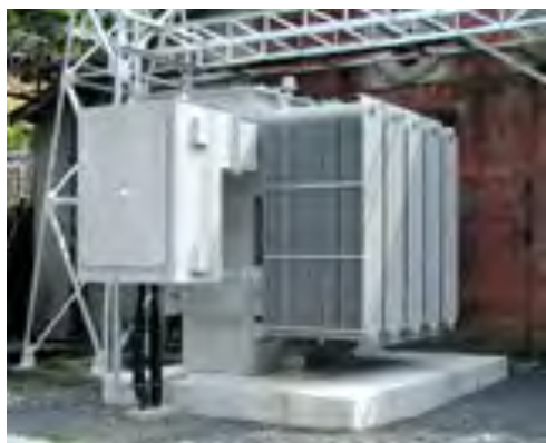
屋外変電所変圧器設置
