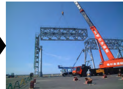
フレーム据付
