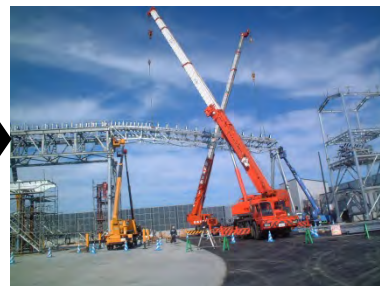
フレーム据付
