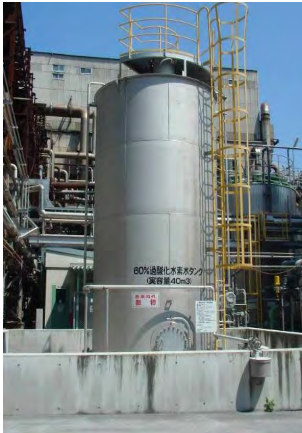
SUS製タンク据付
