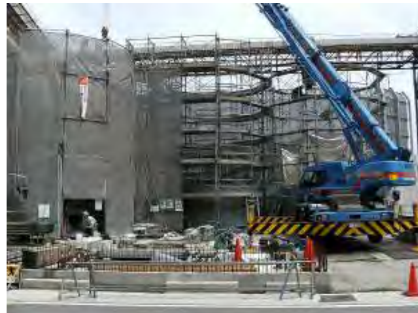
FRP製タンク据付
